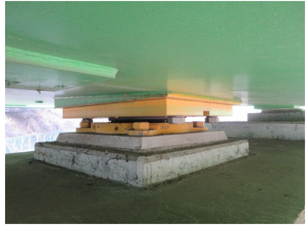
받침장치 상태양호 P2-SH2
