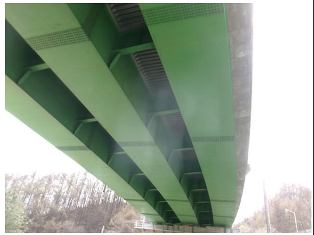
바닥판 하면 및 거더 전경
