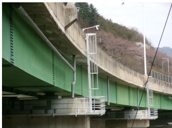
점검시설 상태양호 P1
