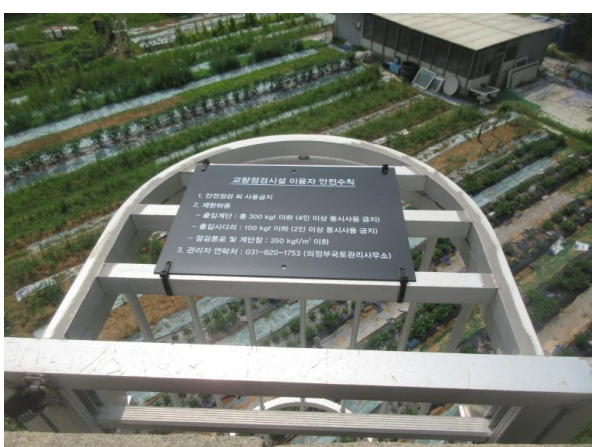
점검사다리 덮개 상태양호 P2
