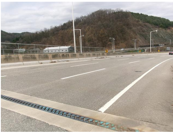
교량 상부 전경
