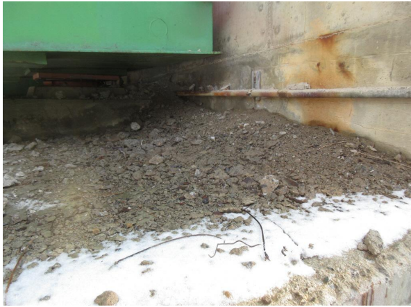
교대 폐콘크리트 적치 A1
